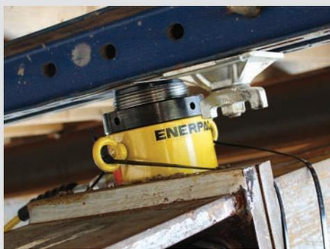
Die Kurzhubzylinder der RSM-/RCS-Serie (bis 100 Tonnen) verfügen über das flachste Profil und können Brücken beim Austausch von Auflagern über kürzere Distanzen anheben, während die Stellringzylinder der CLP-/CLL-Serie (bis 1.000 Tonnen) ein niedriges oder hohes Profil bieten mit dem zusätzlichen Vorteil einer mechanischen Sicherungsfunktion bieten, die (wenn gesichert) die Brücke im Fall eines Druckverlusts in Position hält.
