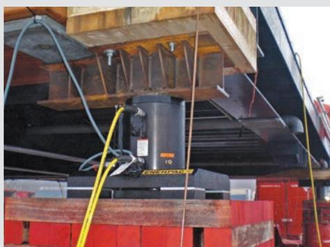
Die Stufenhubsysteme der BLS-Serie (bis 200 Tonnen) können mit einer größeren Hublänge und einer breiten Basis zum stufenweisen Anheben sehr große Distanzen abdecken. Wenn der Zylinder ausgefahren wird, werden unter der Basis Blöcke positioniert, um die Brücken abzustützen. Anschließend wird der Zylinder für den nächsten Stufenhub eingefahren.
